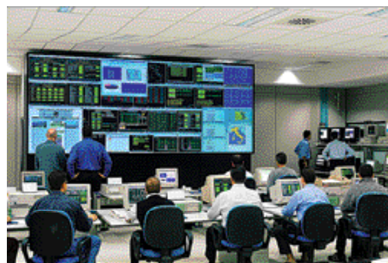
Рис. 2. Диспетчеры на индивидуальных дисплеях контролируют отдельные процессы, готовят информацию для представления на большом экране. Полностью оценить состояние всех процессов и принять необходимое решение позволяет экран коллективного пользования
