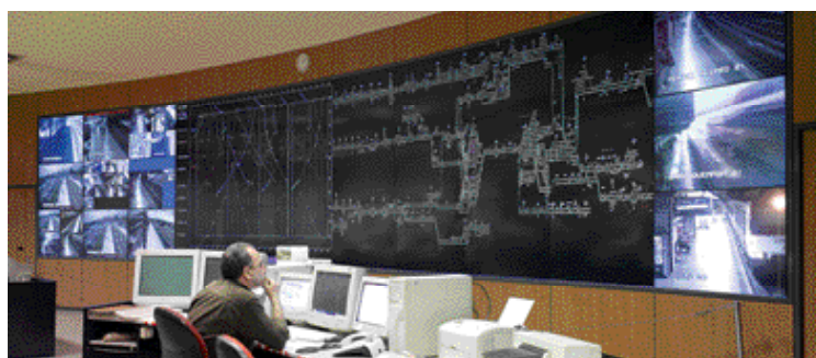
Рис. 1. Одна из областей применения видеостены — центры управления метрополитеном. На одном большом экране диспетчер может контролировать состояние транспортных магистралей, график движения поездов, следить за обстановкой на станциях с помощью изображений, передаваемых с многочисленных видеокамер
